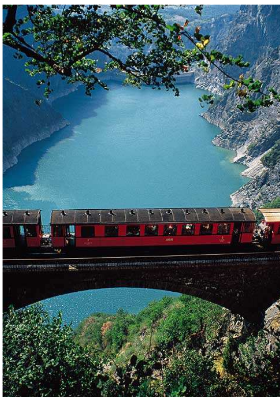
Chemin de fer de La Mure
